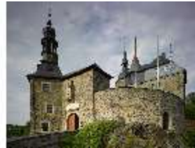
LauBg.I, Vorbau, Blick von Südwesten, DI000291, BSV
