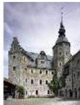
LauBg.I, Innenhof, Blick von SW, DI000288, BSV
