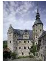
LauBg.I, Innenhof, Blick von SW, DI000289, BSV
