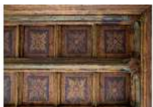
LauBg.II, Holzdecke, Detail (R.13), DI000323, BSV
