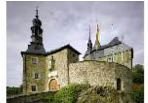
LauBg.I, Vorbau, Blick von Südwesten, DI000293, BSV
